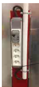
Bloc 4 prises 2P+T avec protection différentielle
